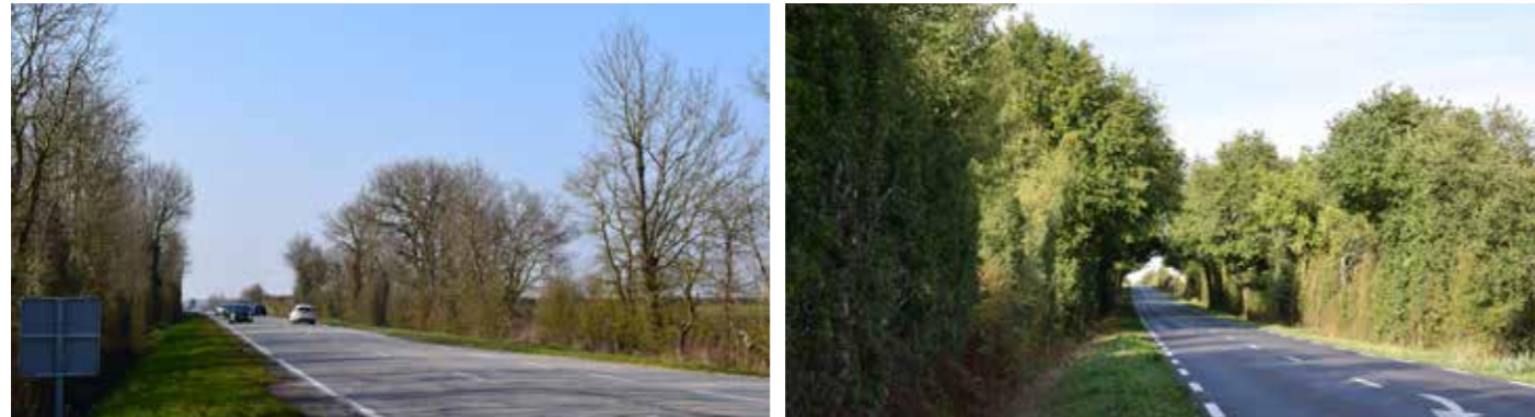
Fig. 24 : Les haies limitent les vues depuis la N149 et la D938TER
