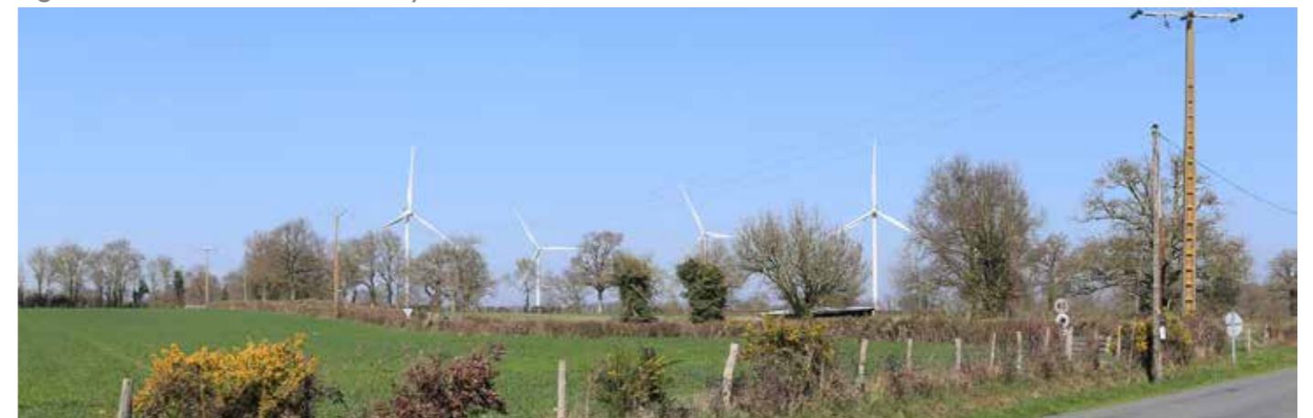
Fig. 61 : Ferme éolienne de Maisontiers-Tessonnière
