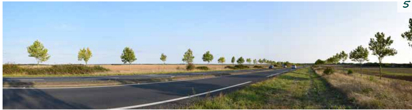
Fig. 38 : Vue horizontale depuis la D938
