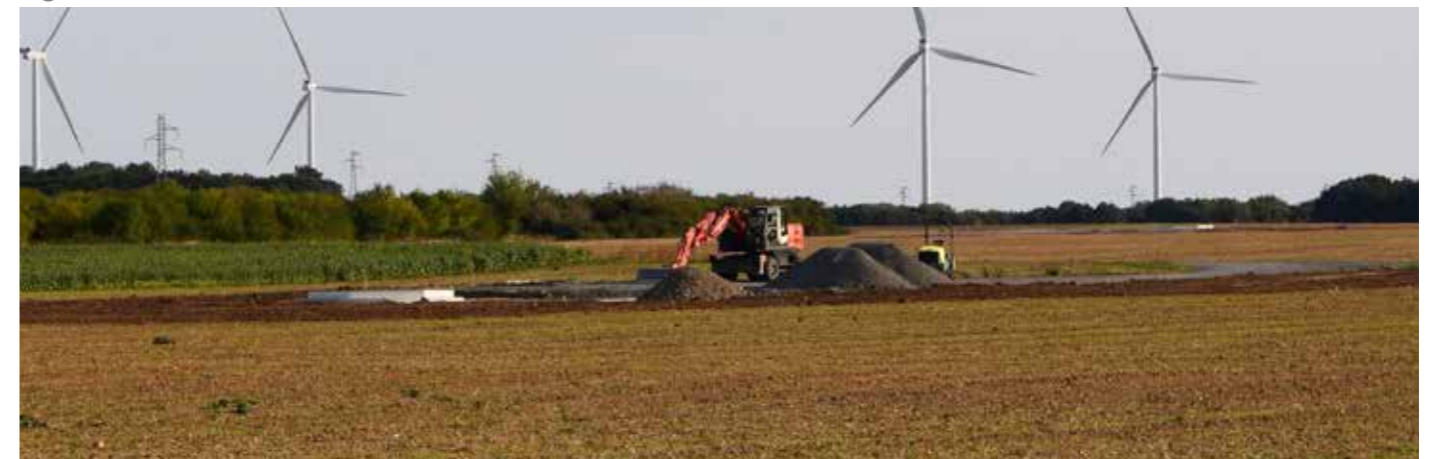
Fig. 59 : Travaux de la Ferme éolienne de Saint-Généroux-Irais
